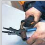
отстранување и монтирање на млазник
