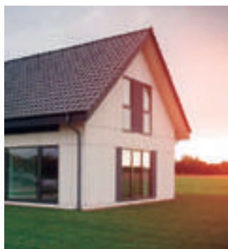
Pasivna kuća u Tychowu pored Stargarda Szczecinskog, Poljska. Aquarea
