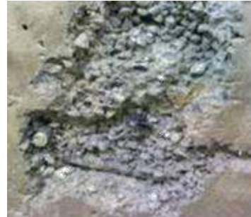
Дефекти кај конструкција (вдлабнатини во бетон, ронење и нетретирани отвори во бетонски ѕид за поврзување со оплата)
