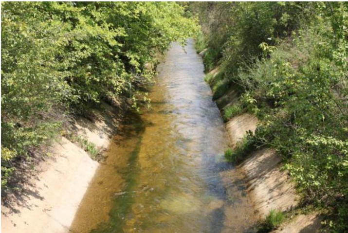
Типски дренажен трапезен канал R=1:25
