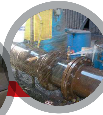
Заптивање цевки што пропуштаат
