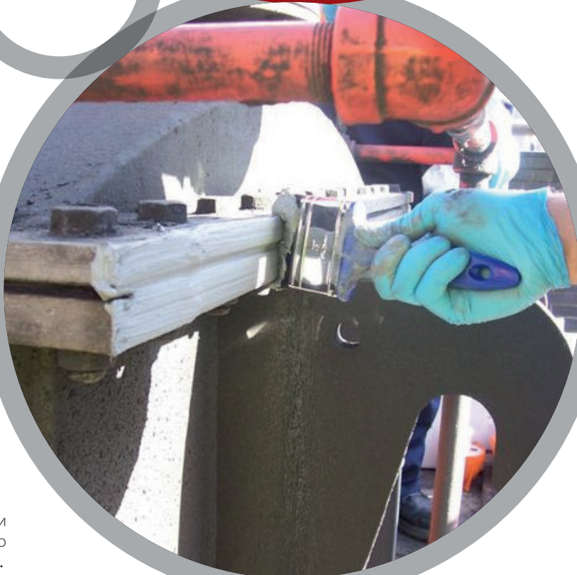
Заптиване на фланша
