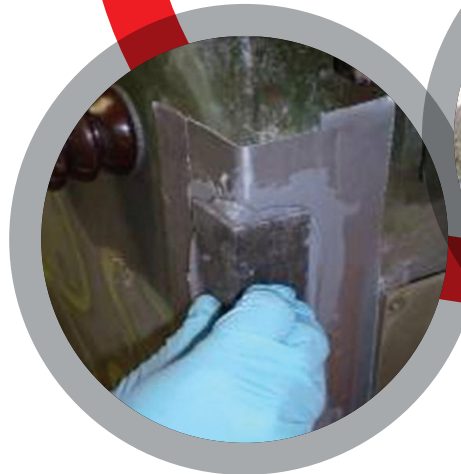
Врзување на плочки со ладна постапка
