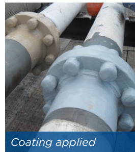
Belzona wrap applied
