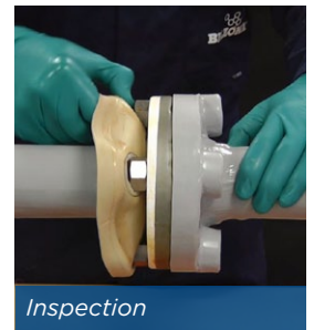
Belzona wrap applied
