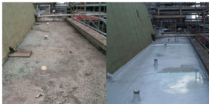
Заливање на кровот и спојот со сидот
