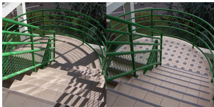
Безбедносен систем применет на плочки за скали
