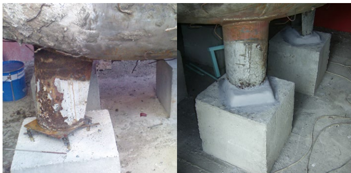
Реконструкција на потпора од метален сад
