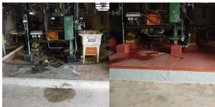
Реконструкција на танквана за хемикалии
