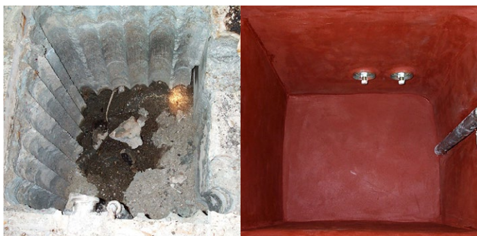
Реконструкција на канал со хемиски отпорен материјал
