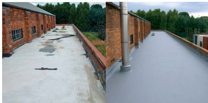
Истрошениот битуменски покрив е отпорен на вода
