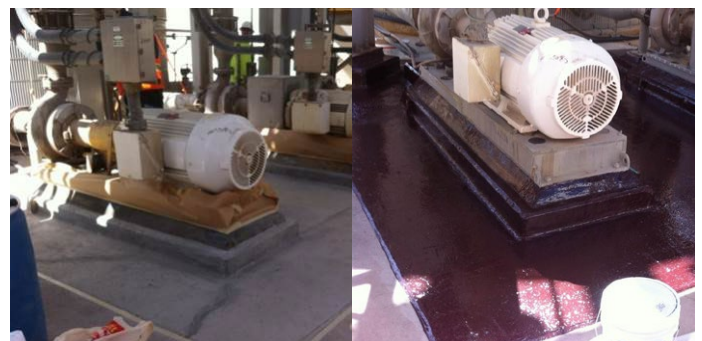
Бетонска површина заштитена од агресивни хемикалии
