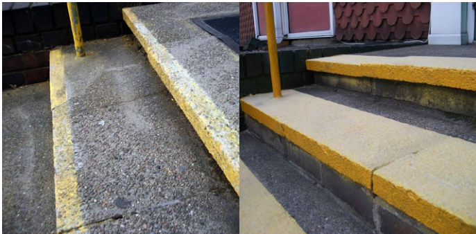
Безбедносен систем применет на бетонски скали
