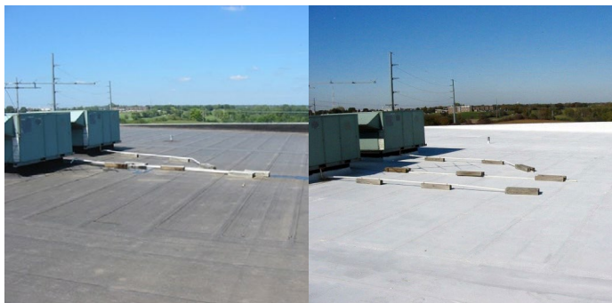
Кров заштитен од влегување на вода
