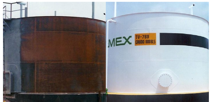
Резервоар заштитен од надворешна корозија
