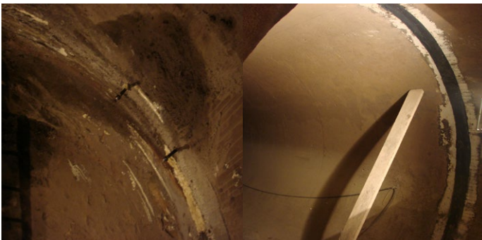
Залепен спој на подземни бетонски цевки
