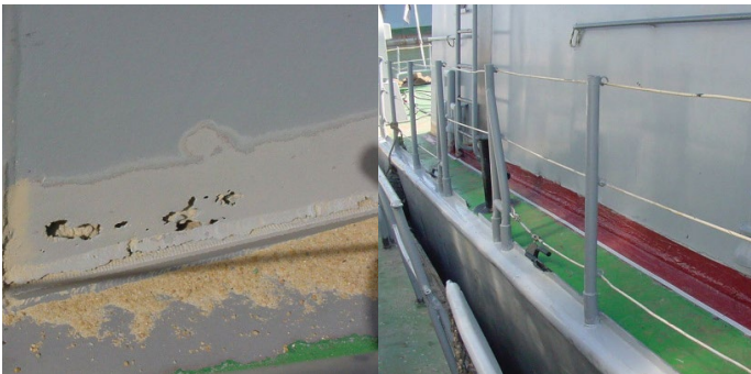
Затворен спој помеѓу платформа и резервоар
