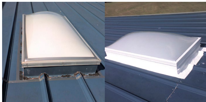
Кровни прозори запечатени со водоотпорна мембрана
