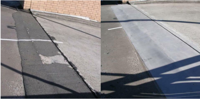
Заптивање на дилатационен спој
