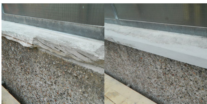
Поправени бетонски прагови
