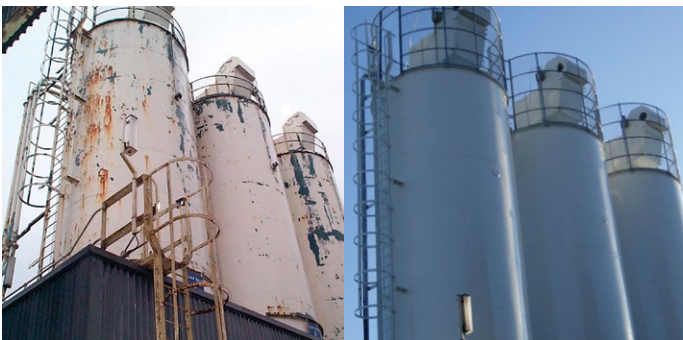
Премаз за долготрајна заштита на силоси за шеќер
