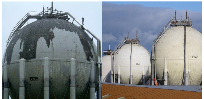
LNG spheres insulation protected
